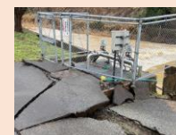
水道の復旧 (被災した浄水場)
